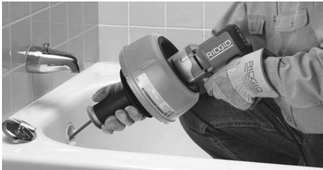
Figura 9 – Spingere il cavo in basso all'interno della tubazione dello scarico
