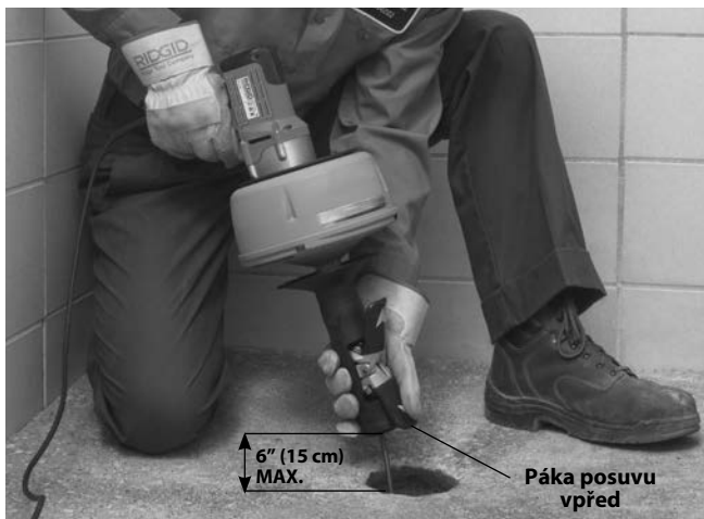
Obrázek 10 – Protlačení kabelu pomocí AUTOPOSUVU
