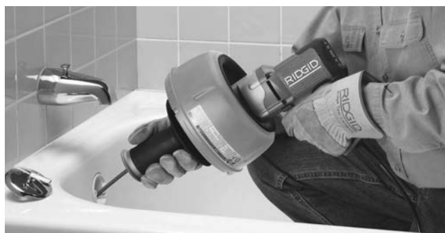
Obrázok 9 – Zatláčanie kábla do potrubia odtoku
