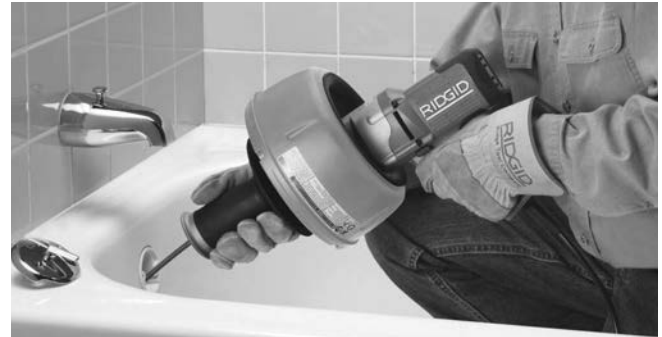
Şekil 9 - Spiral Kanal Hattına İtin
