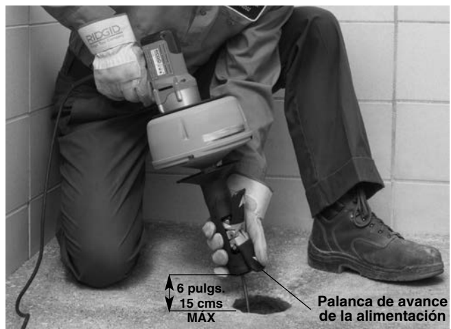
Figura 10 – Alimentación de cable con la ayuda de la AUTOFEED
