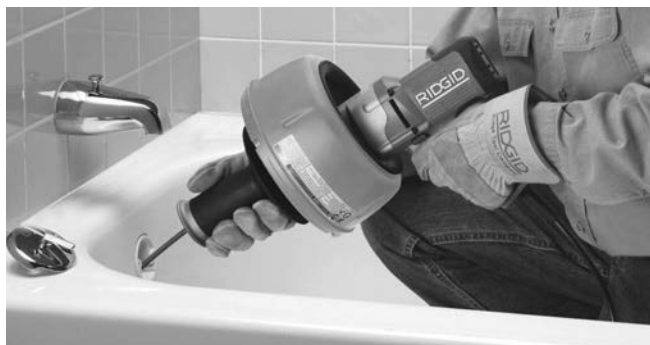
Figura 9 – Empurrar o cabo dentro da tubagem
