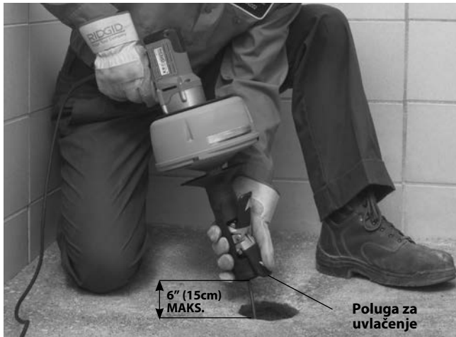
Slika 10 – Uvlačenje sajle kroz sustav AUTOFEED
