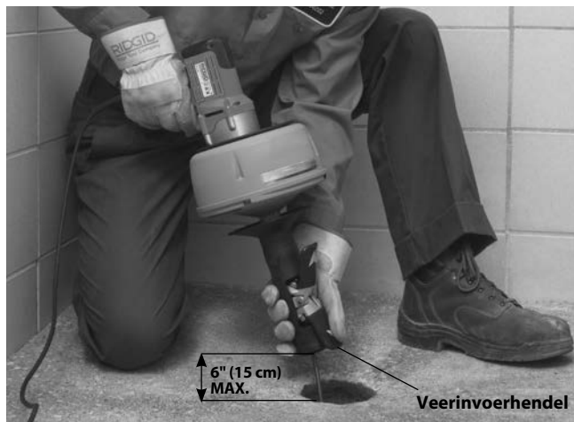
Figuur 10 – Veer invoeren met AUTOFEED
