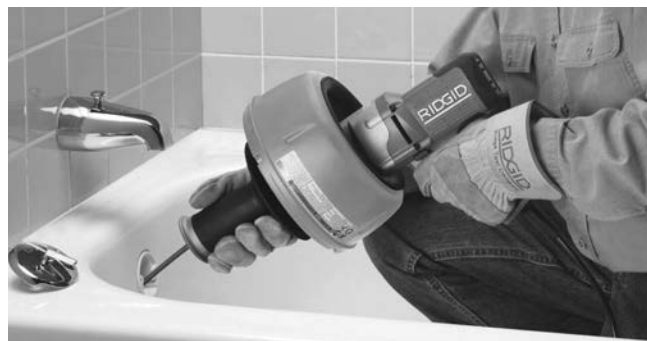
9-сурет – Кабельді ағын желісінен өткізу
