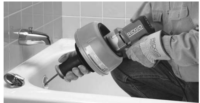
Rysunek 9 – Wpychać sprężynę do odpływu
