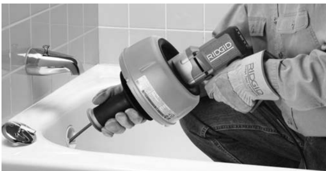
Figure 9 – Pousser le câble dans la conduite
