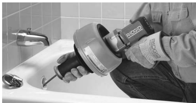
Figur 9 – Skyv kabelen ned i avløpsrøret
