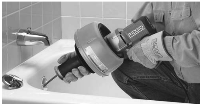
Figura 9 – Împingeți cablul de-a lungul conductei de canalizare
