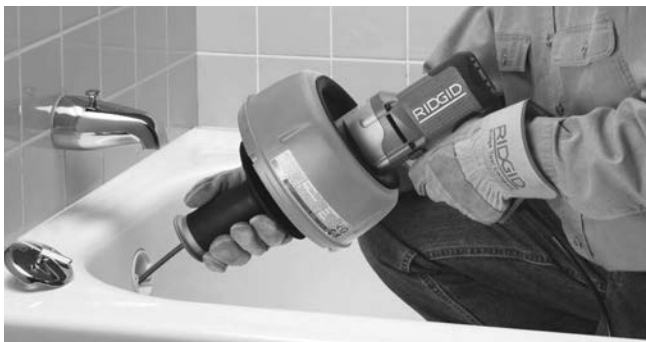
Obrázek 9 - Zasunujte kabel dolů do odpadového potrubí
